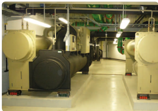
Obr.: Chladiace jednotky TRANE typ CVGF 650 700B 700C s dvojstupňovým turbokompresorom
