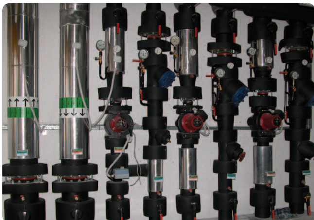
Obr.: Rozdeľovač ústredného vykurovania pre VZT zariadenia s čerpadlami Grundfos
