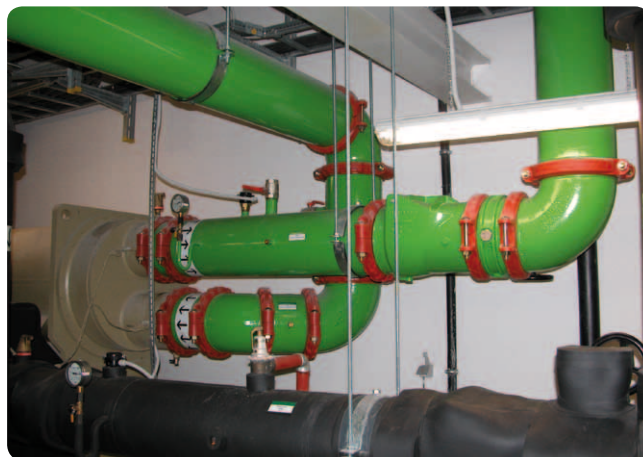
Obr.: Kondenzátorový okruh s teplotným spádom 27/35^{\circ}\text{C} , použité spoje a armatúry VICTAULIC DN 300
